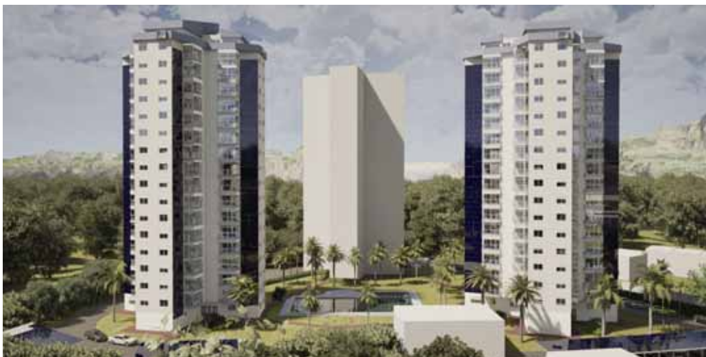
Edificios residenciales en Benidorm que se convertirán en los primeros del continente en transformar su envolvente en una fuente activa de generación de energía renovable. Con aproximadamente 1.200 m 2 de vidrio fotovoltaico instalado, las nuevas fachadas producirán alrededor de 190.000 kWh de electricidad al año.
