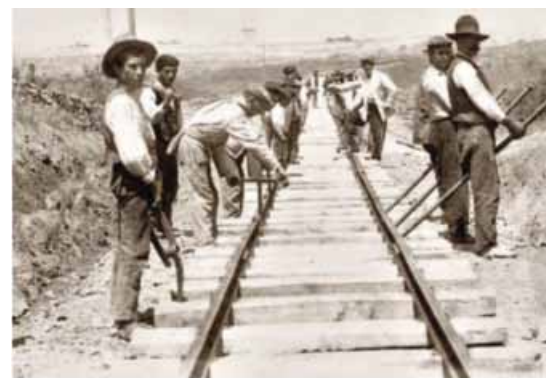
Colocación de vías de la línea Linares-La Carolina (ha. 19) Foto Alcañiz AHML-FFDA 01020491907 Col. CRS
