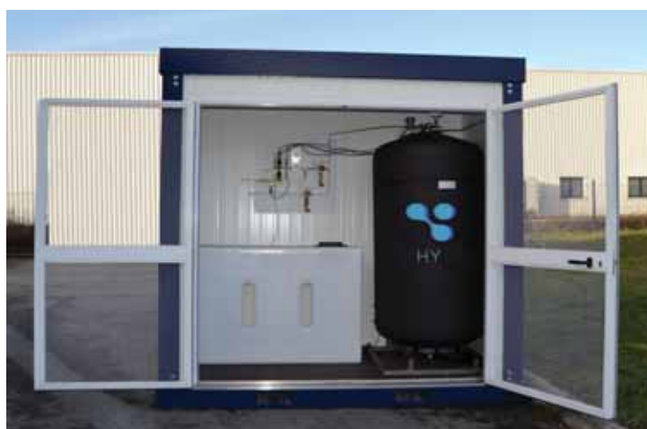
Hy2Green. Arriba, estación de producción de hidrógeno, pila de combustible y un almacén de hidrógeno a pequeña escala. Debajo, integrantes del proyecto trabajando y en un encuentro internacional.
