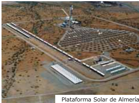
Plataforma Solar de Almería.
