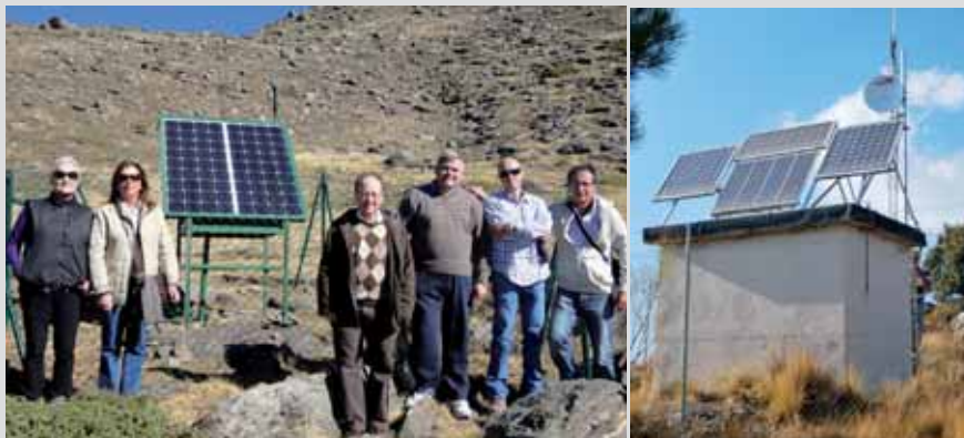
Bajo estas líneas, Estación de Medida de Resonancias de Schumann, en Sierra Nevada. A la derecha, Estación de medición en Calar Alto, en la Sierra de los Filabres.
