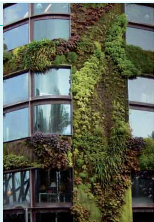
de distintas zonas del Campus con soluciones hidropónicas con recogida de drenajes, o un sistema autosostenible para la captación de aguas de lluvia.
